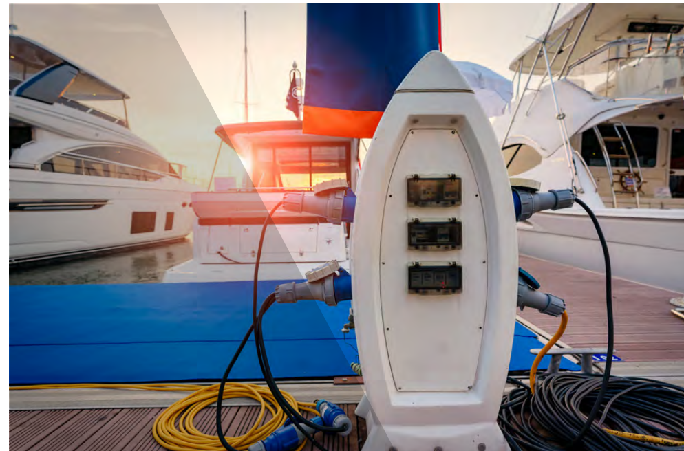
Un punto di ricarica in corrente alternata per imbarcazioni
